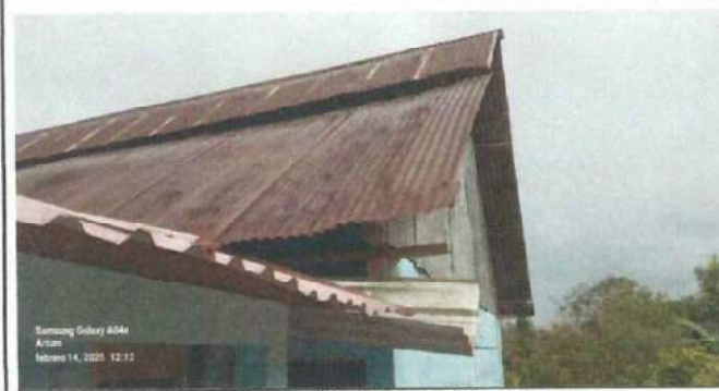
Foto 5: SUSTITUCION DE LAMINAS EN MAL ESTADO
