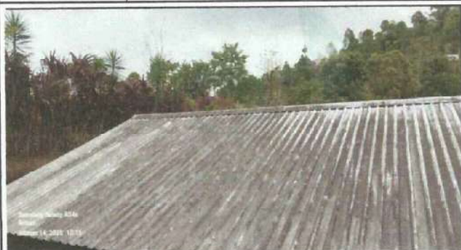
Foto 1: SUSTITUCION DE LAMINAS EN MAL ESTADO EN AULAS
