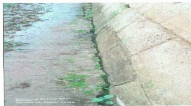
Foto 4: MANTENIMIENTO DE PARED DE AULAS
